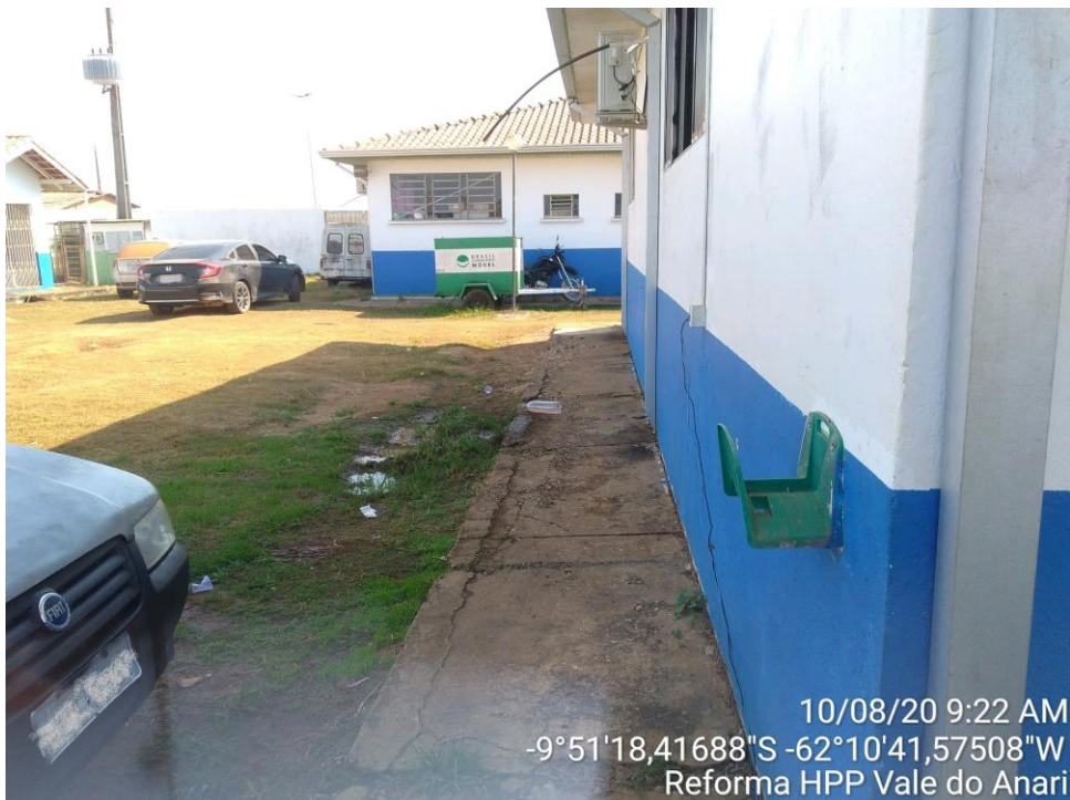
Figura 14 – Reforma da calçada do entorno do prédio.
