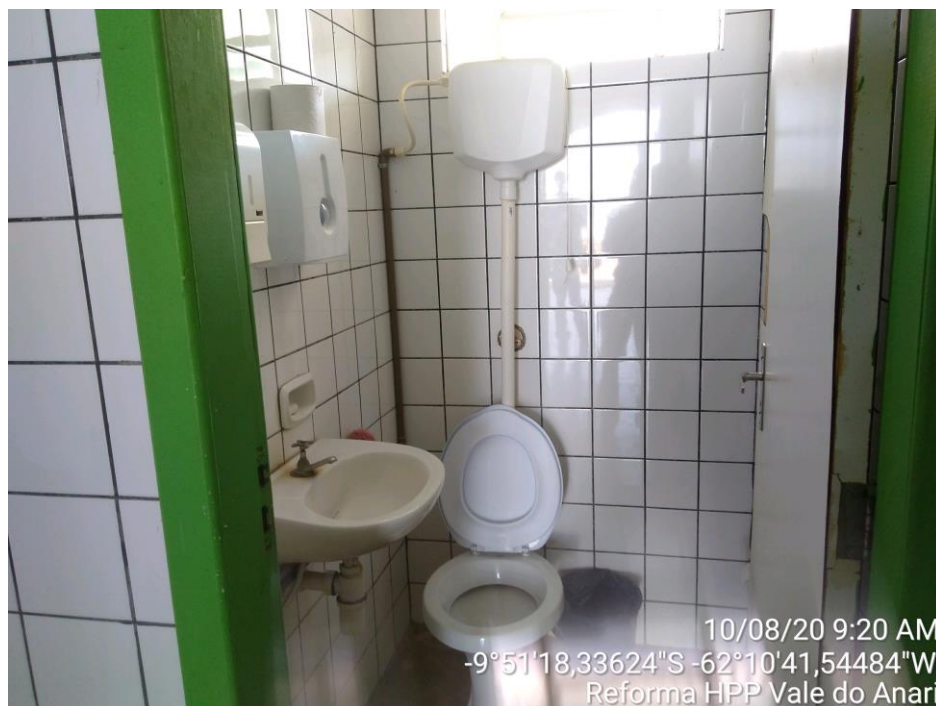
Figura 3 – Reforma e adequação dos banheiros da recepção.
