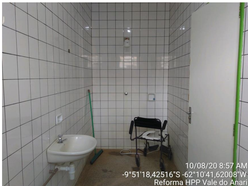
Figura 2 – Substituição lavatório enfermarias.
