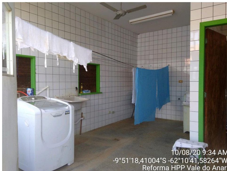
Figura 6 – Instalação de lavatório sala de observação, depósito expurgo e roupeiro.
