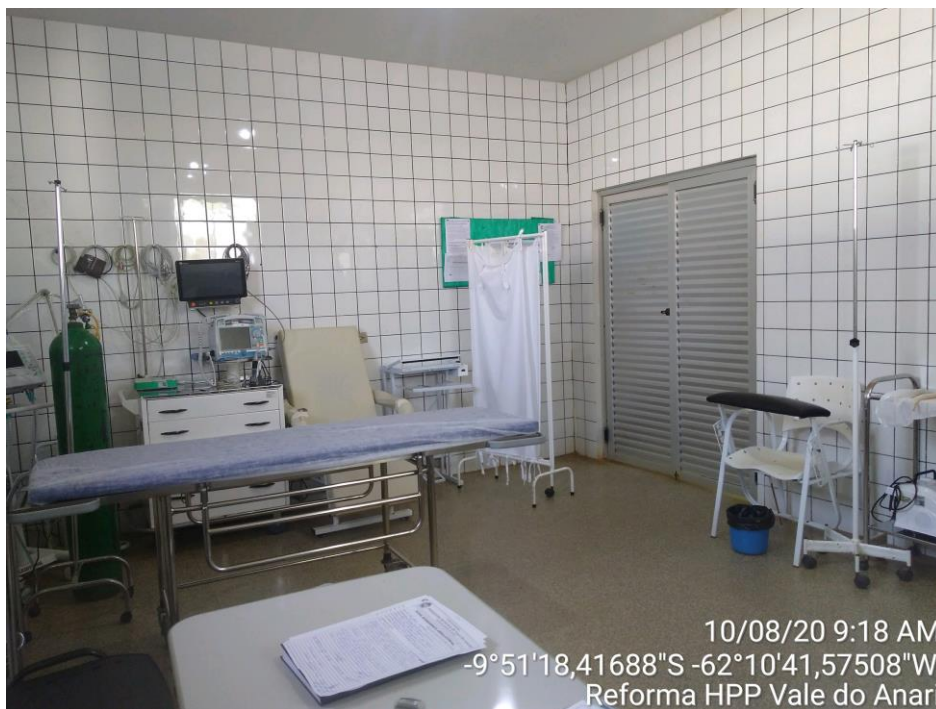
Figura 4 – Reforma e adequação do pronto socorro.
