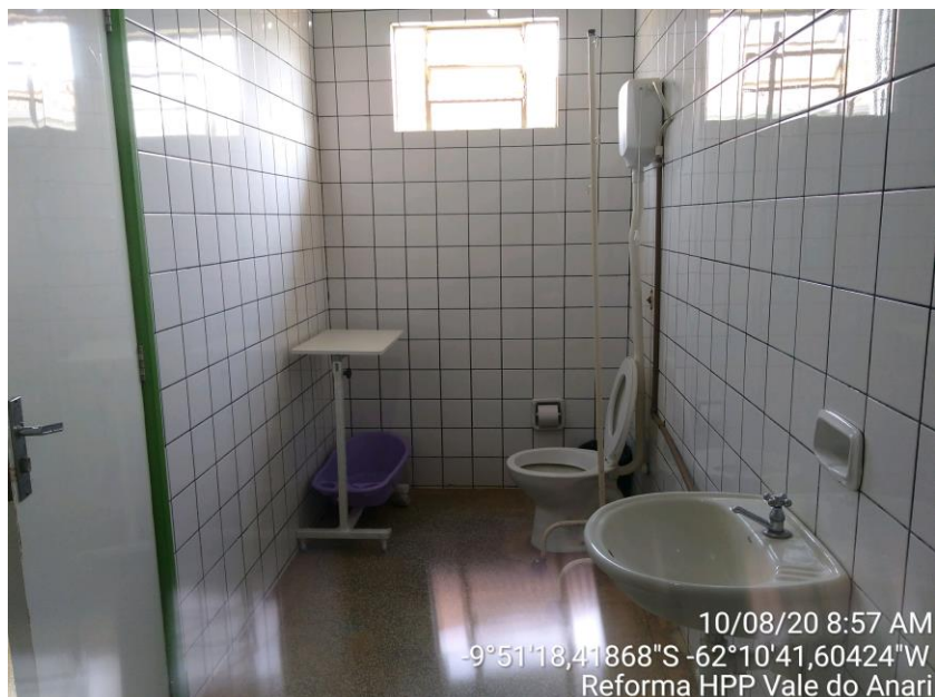
Figura 1 – Reforma dos banheiros das enfermarias.
