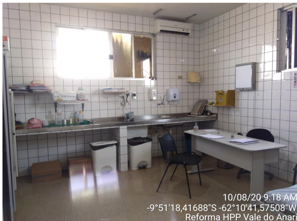
Figura 5 – Reforma e adequação do pronto socorro.
