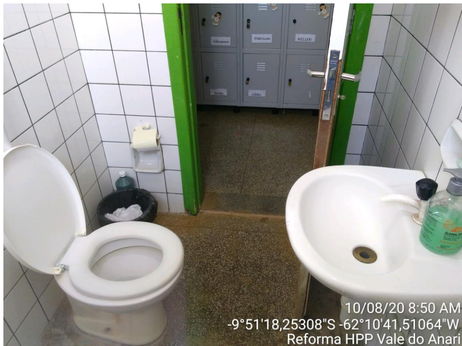
Figura 13 – Reforma WC sala de estar para enfermeiras.
