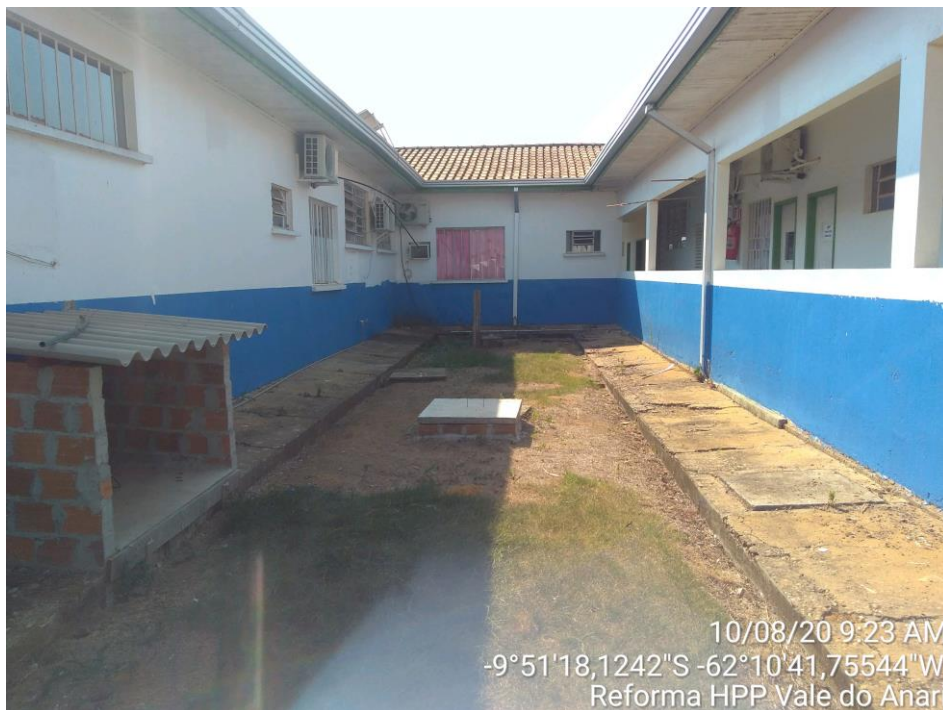
Figura 15 – Remoção e instalação (substituição) de portas e janelas existentes.
