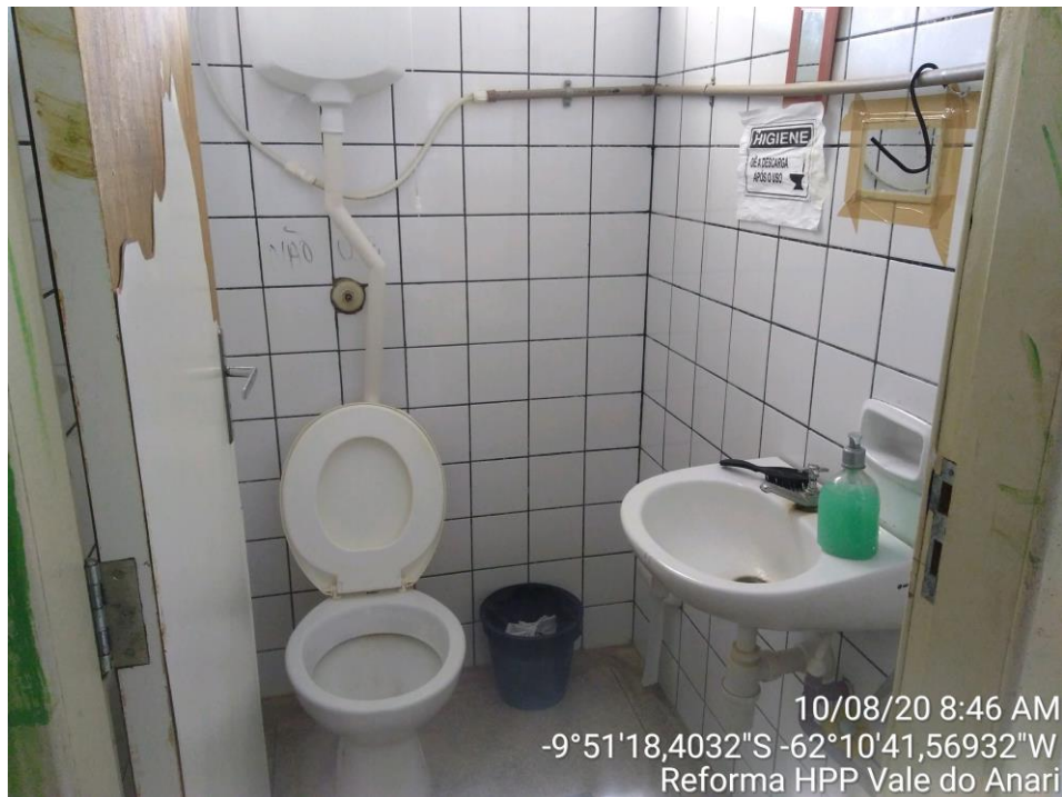
Figura 12 – Reforma WC sala de estar para motoristas.
